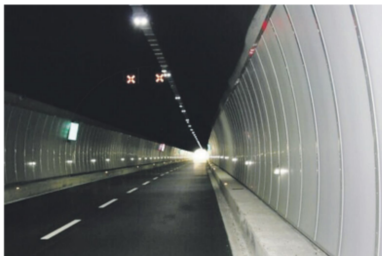
L'interno della galleria di Quarto
